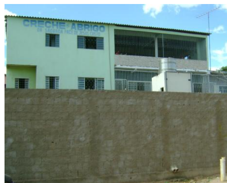
FACHADA DO ABRIGO
